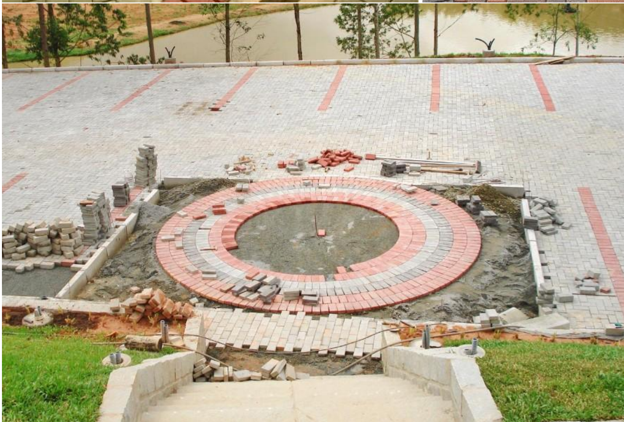
Descrição: Exemplos de assentamentos das beiradas e assentamento em curvas/ formato circular
