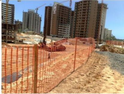
Figura 2: Modelo de isolamento com tapume tipo cerquite.
