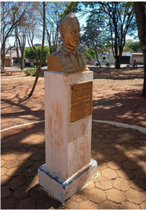
Monumento existente no local a executar reforma da base de alvenaria e pintura do busto com tinta automotiva, na cor a ser definida pela Secretaria de Desenvolvimento Municipal;
