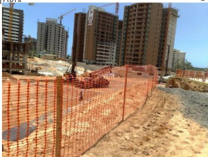
Figura 2: Modelo de isolamento com tapume tipo cerquite.
