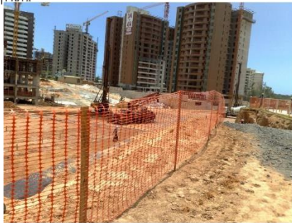
Figura 2: Modelo de isolamento com tapume tipo cerquite.
