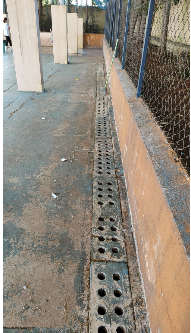
Canaleta na quadra poliesportiva
