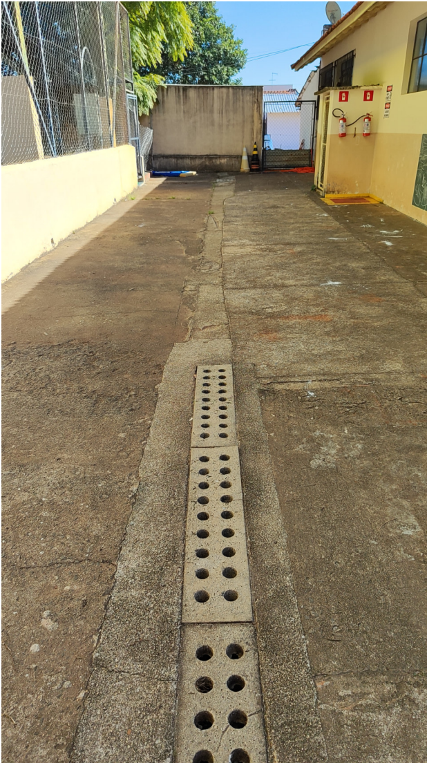
Canaleta no pátio
