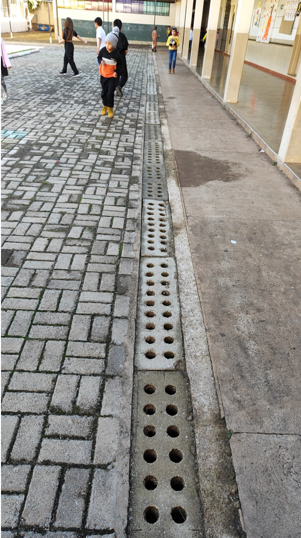
Canaletas no pátio da escola
