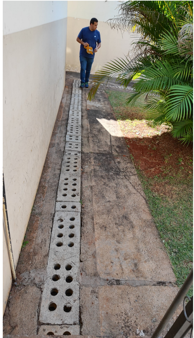
Canaleta na área de entrada da escola
